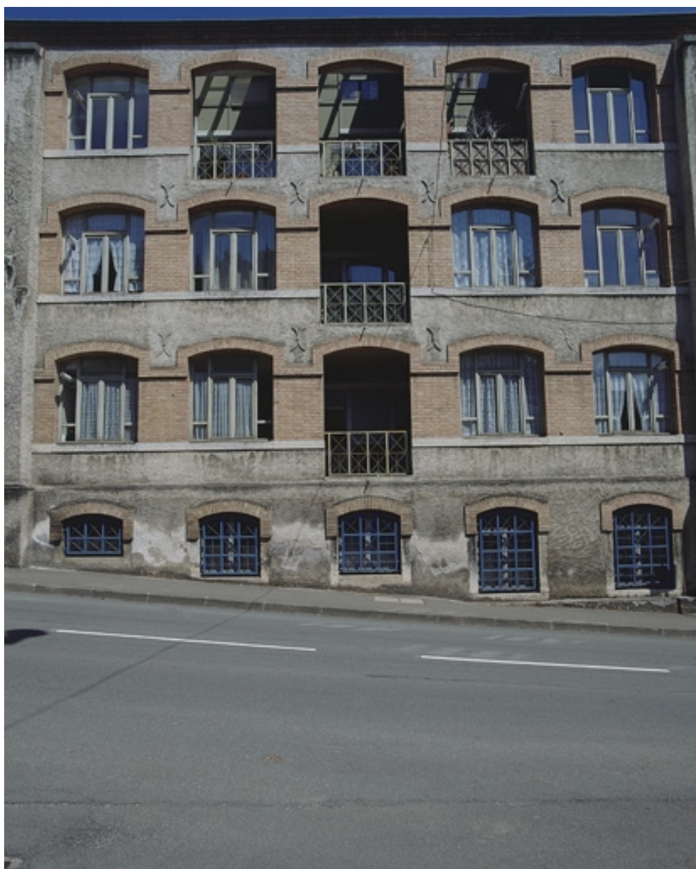
Travées de la façade antérieure.
