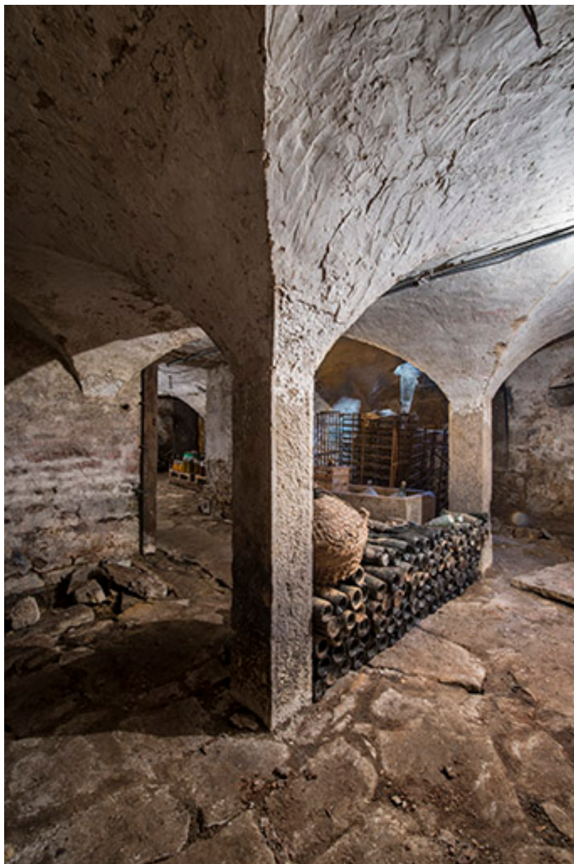
Détail d'une colonne supportant les voûtes.
