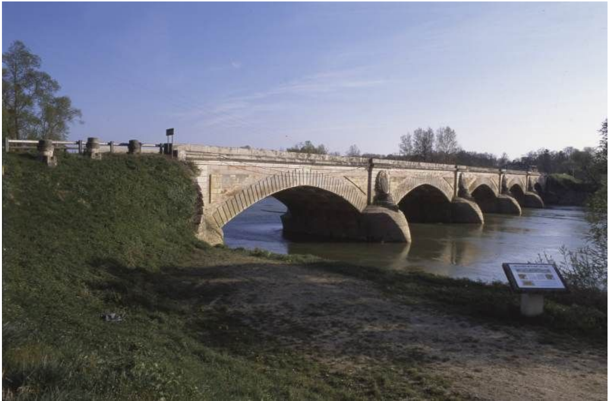
Vue d'ensemble de trois-quarts gauche, en aval.
