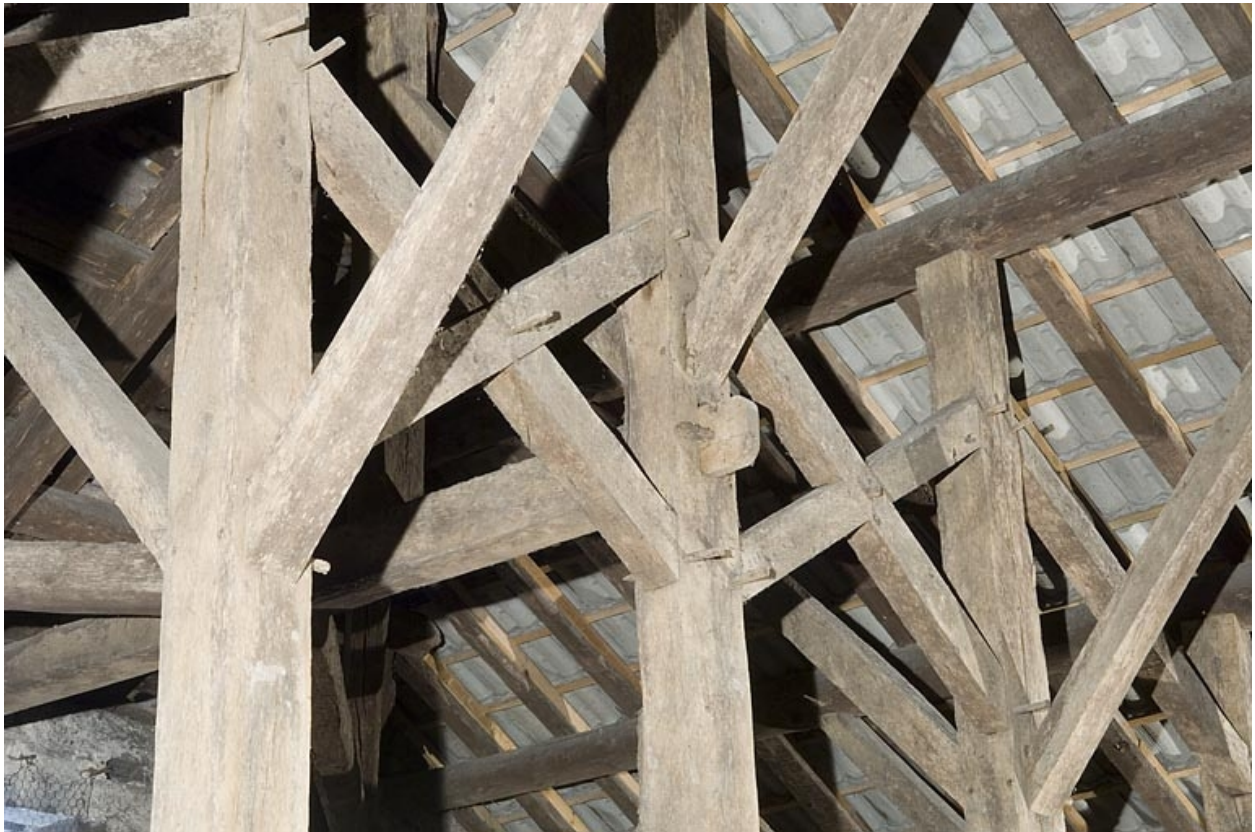
Charpente du fenil. Détail de partie haute (contrefiches et croix de Saint-André).
