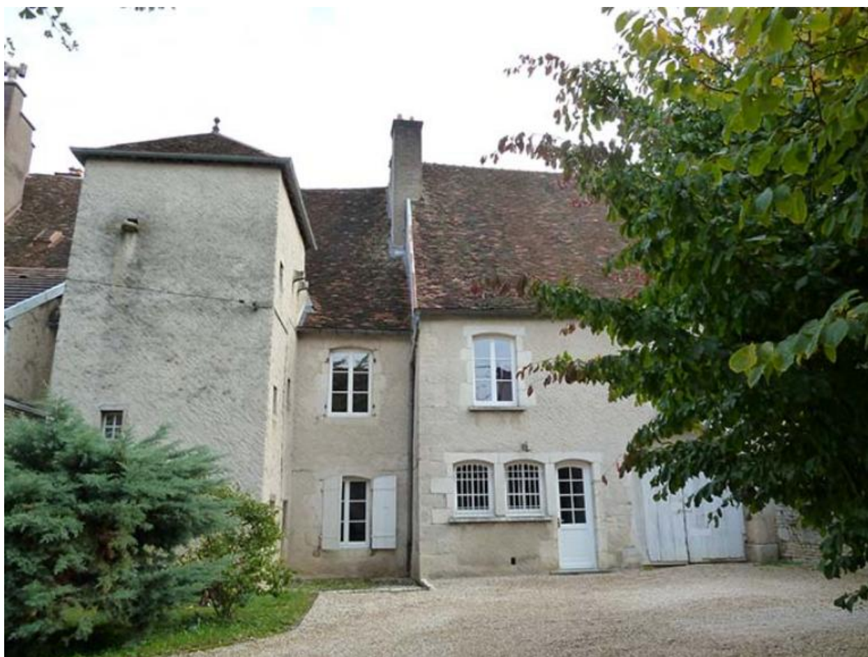
Vue générale ouest
