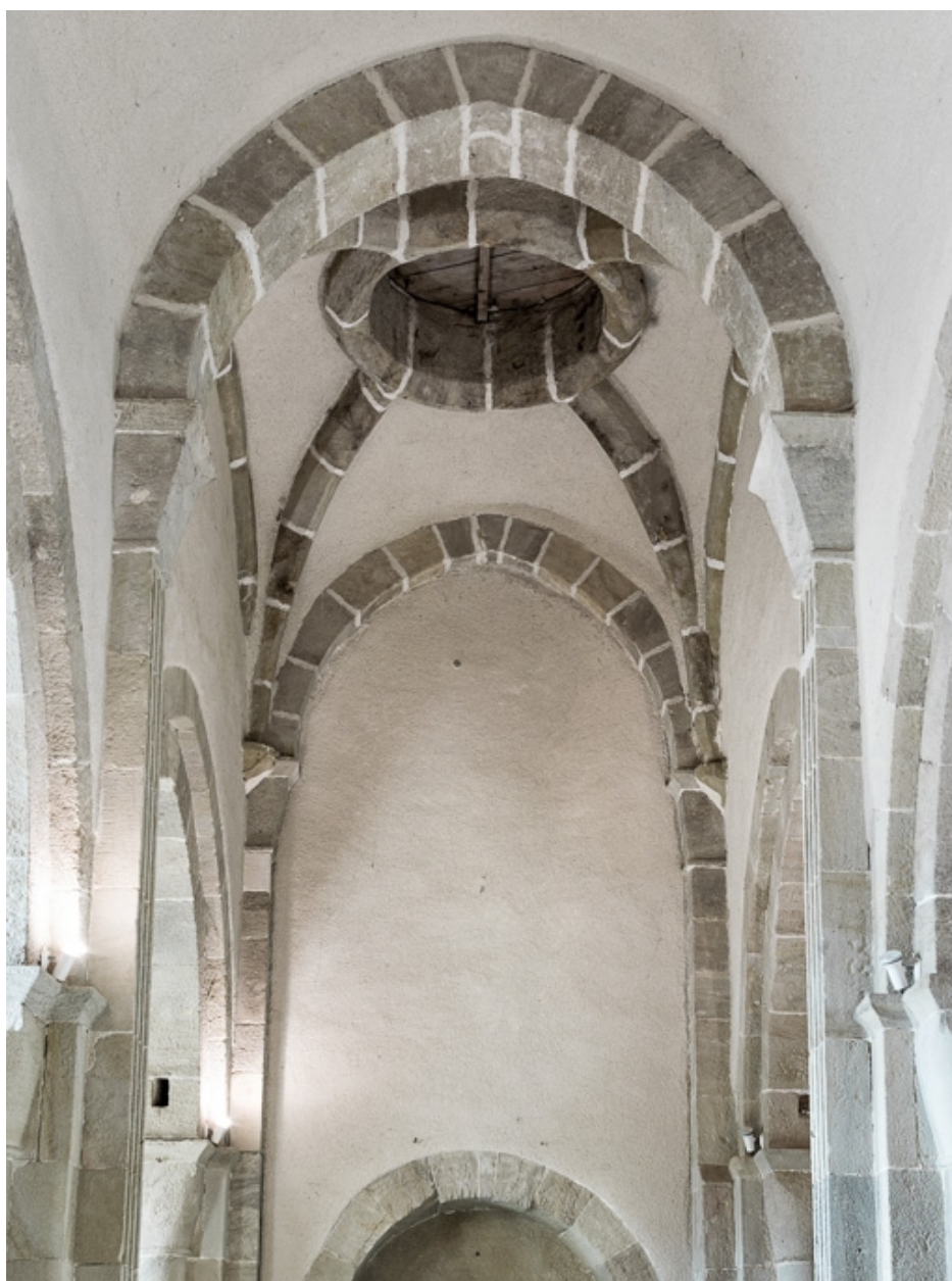
Travée sous clocher.
