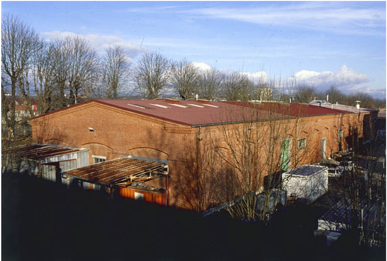
Magasin et entrepôt industriel.
