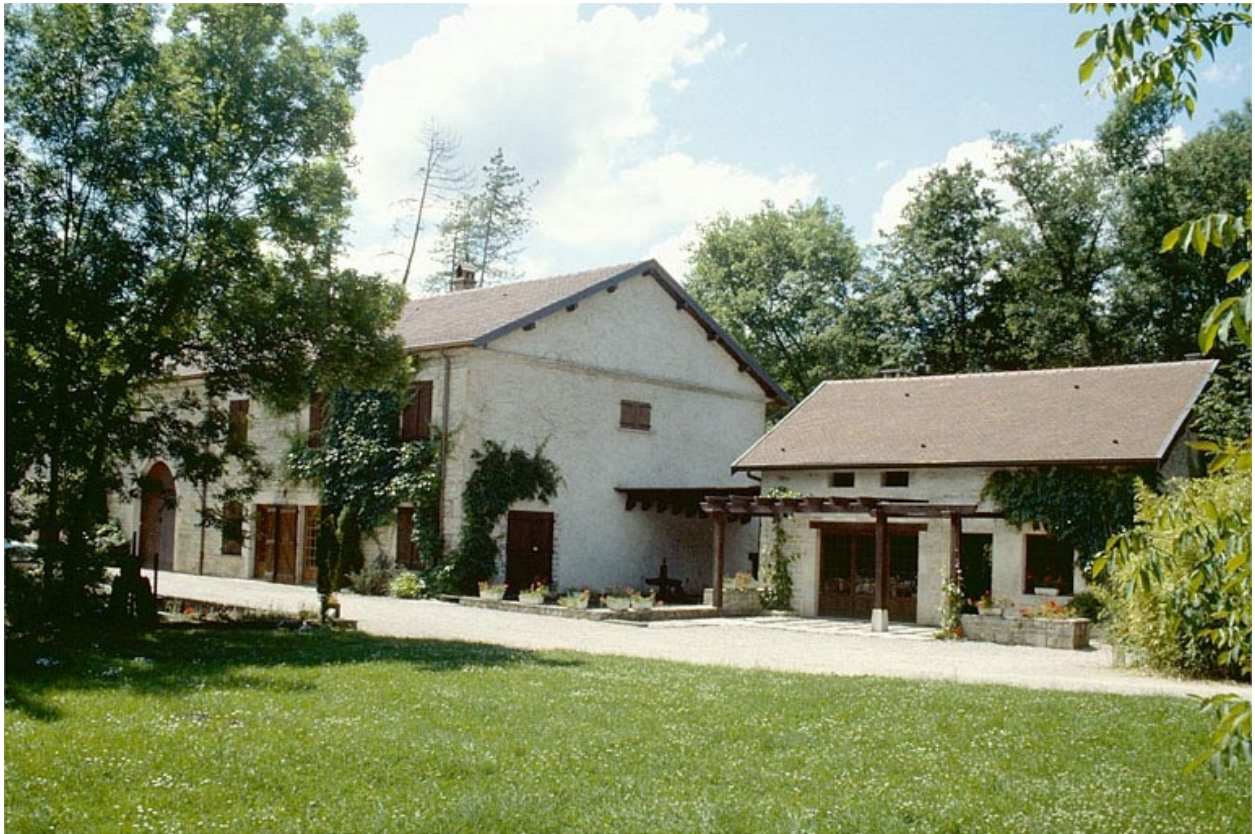
Logement patronal, bâtiment d'eau et ancienne scierie.
