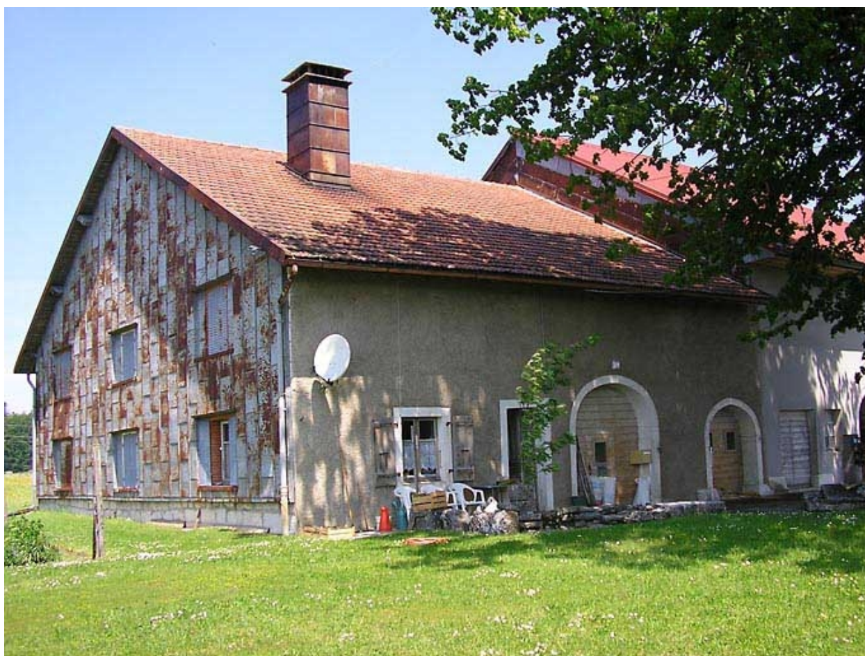
Vue de la façade antérieure.
