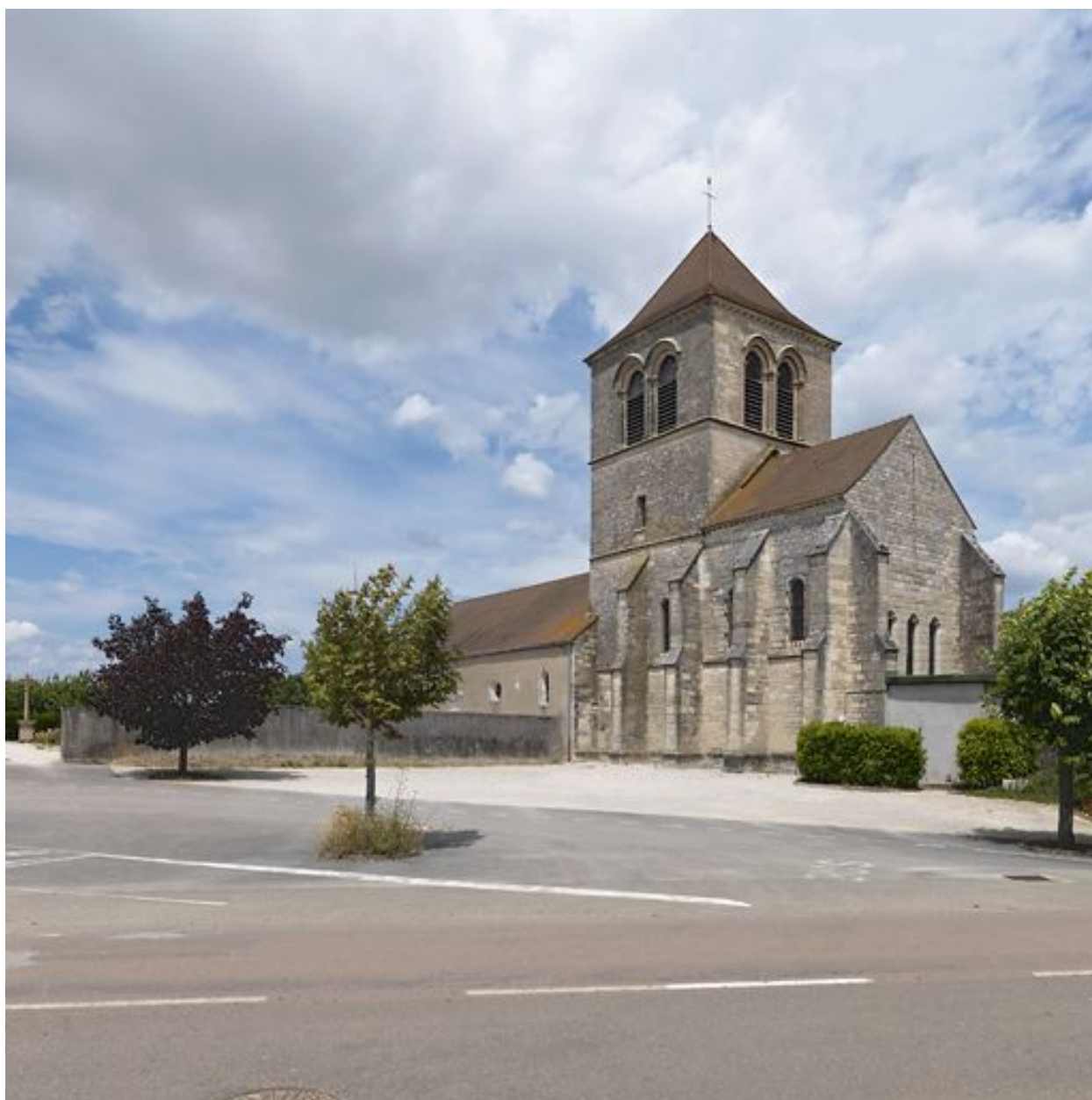
Eglise Saint-Pierre : vue d'ensemble.
