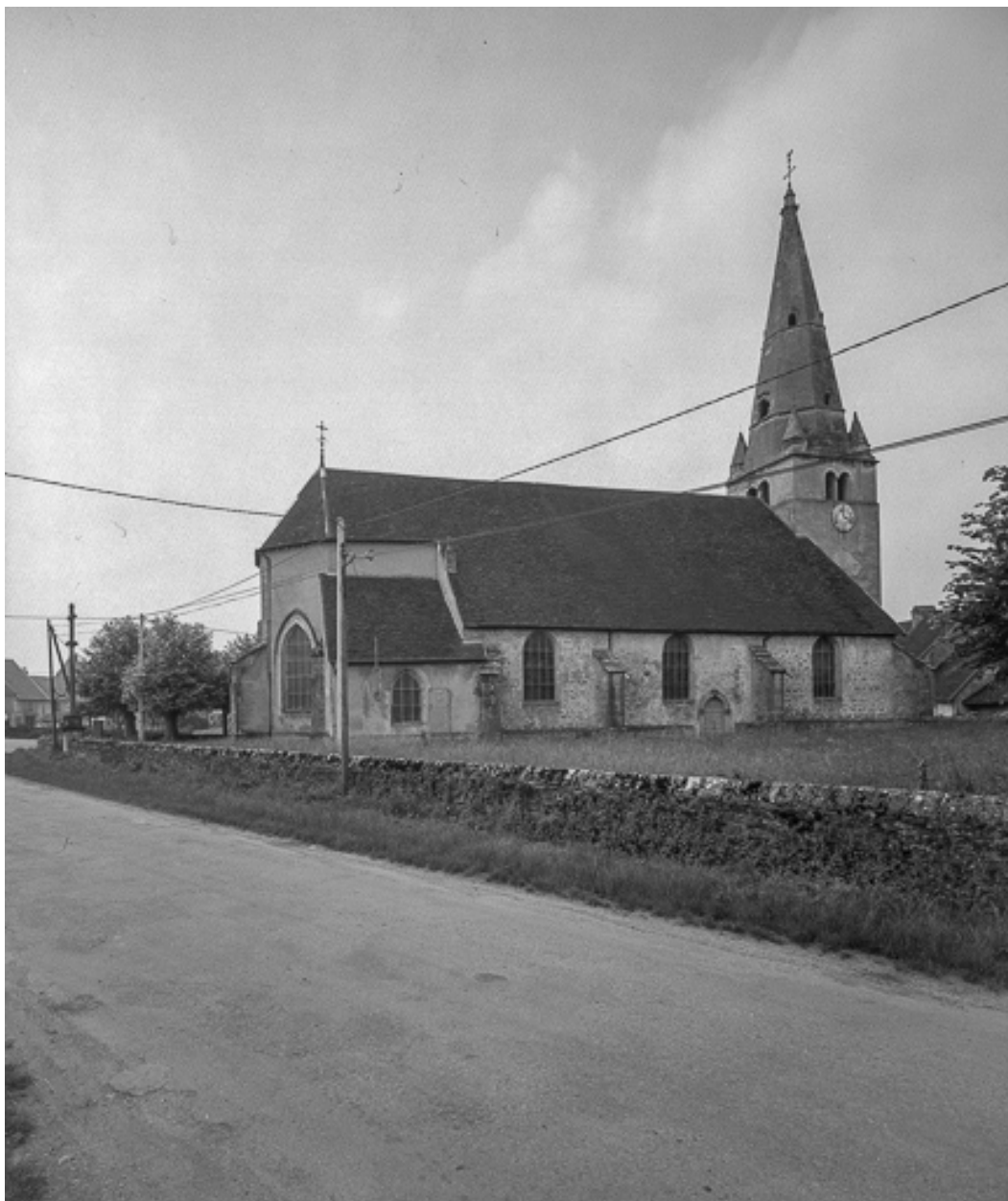
Façade latérale nord.
