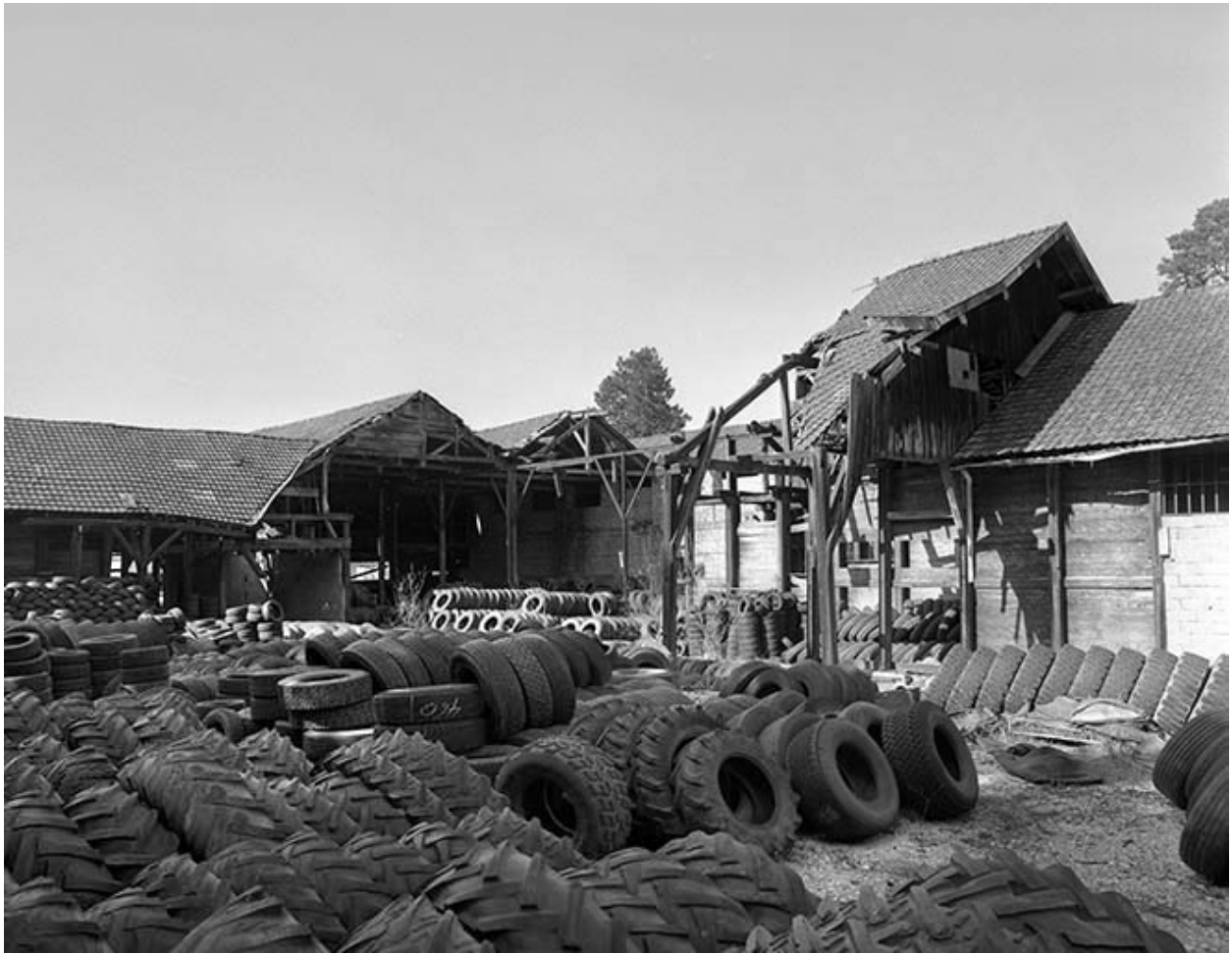
Magasins industriels depuis le nord.
