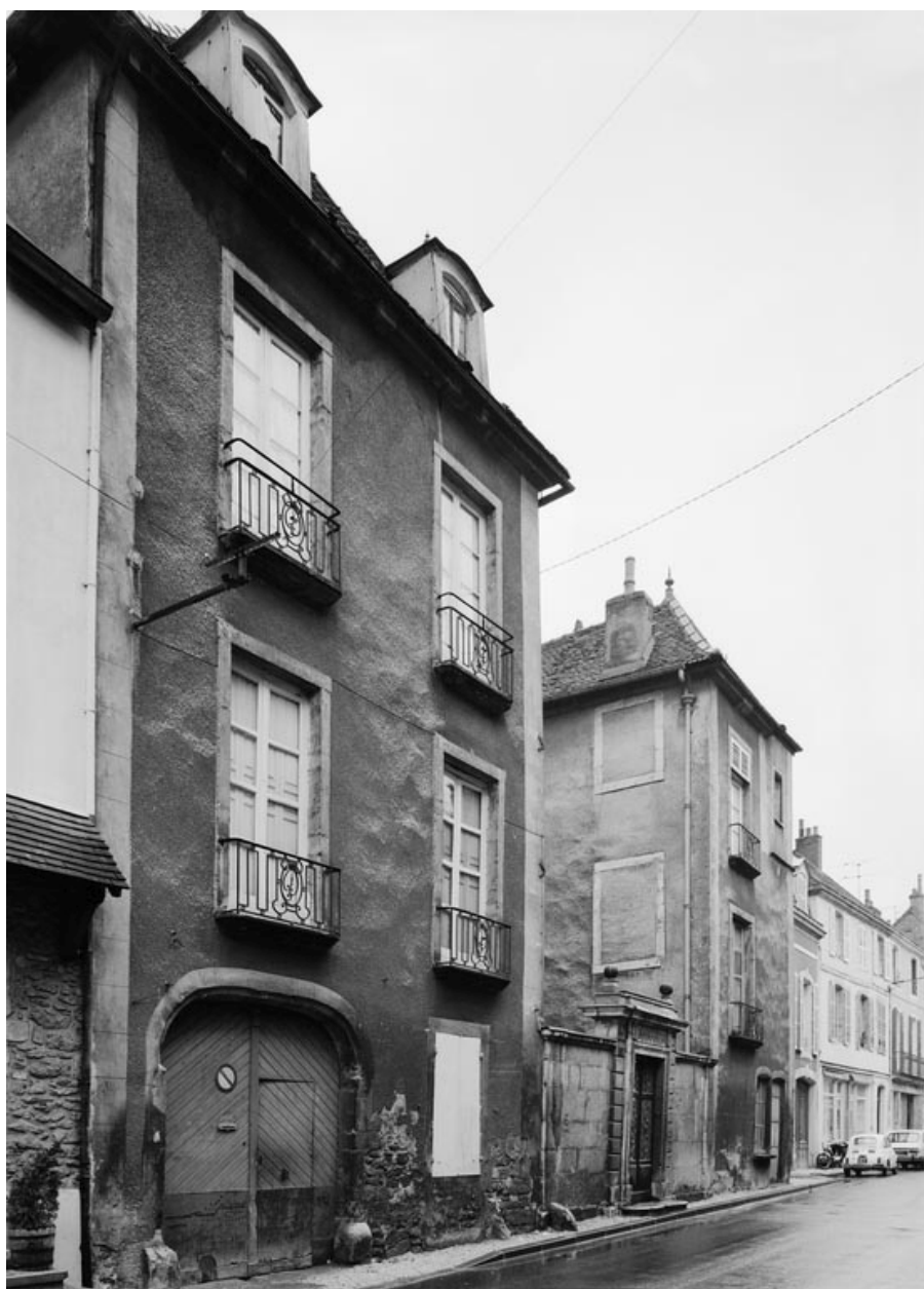
Façade principale, vue de 3/4 gauche.
