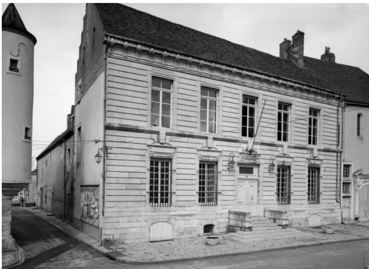
Bâtiment principal et bâtiment des prisons.
