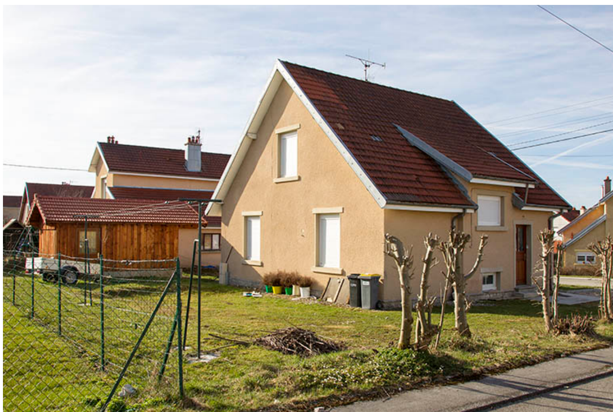
Façades latérale gauche et postérieure.
