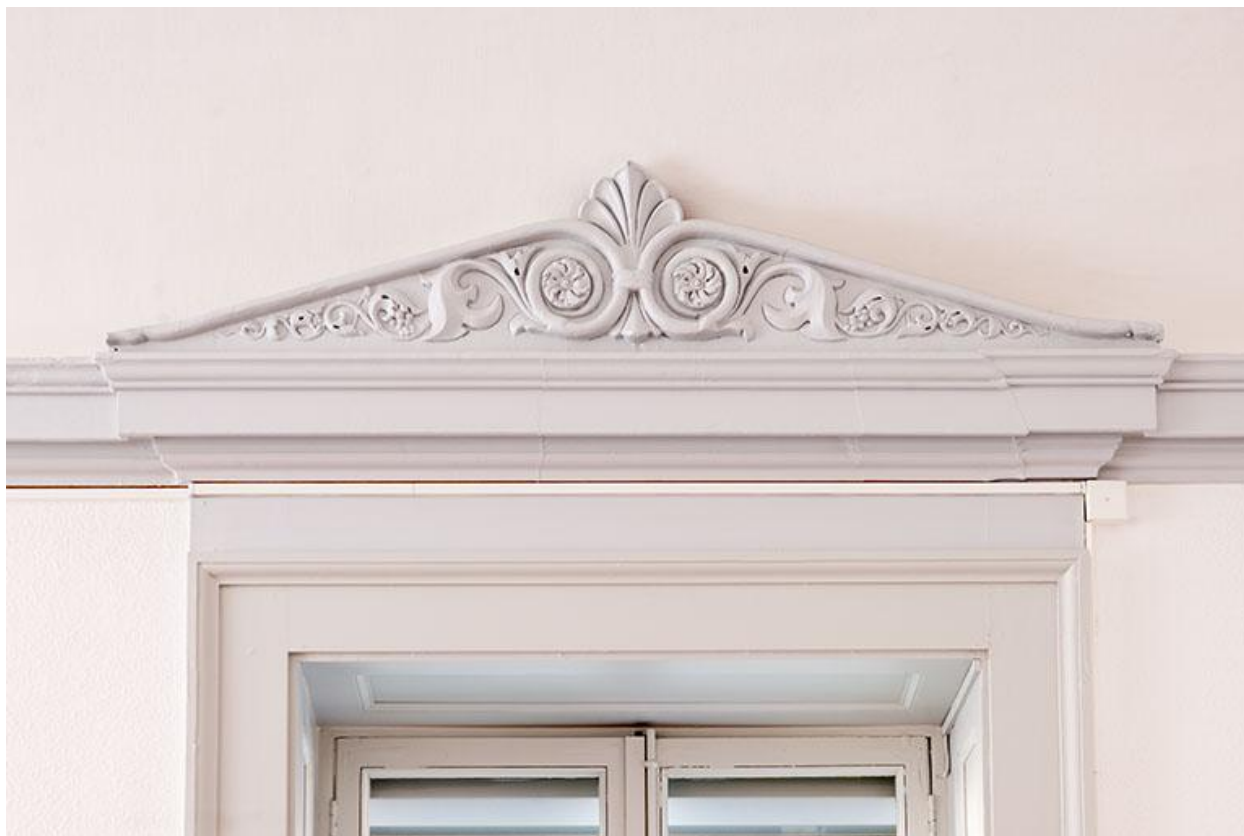
Détail du décor surmontant la baie
