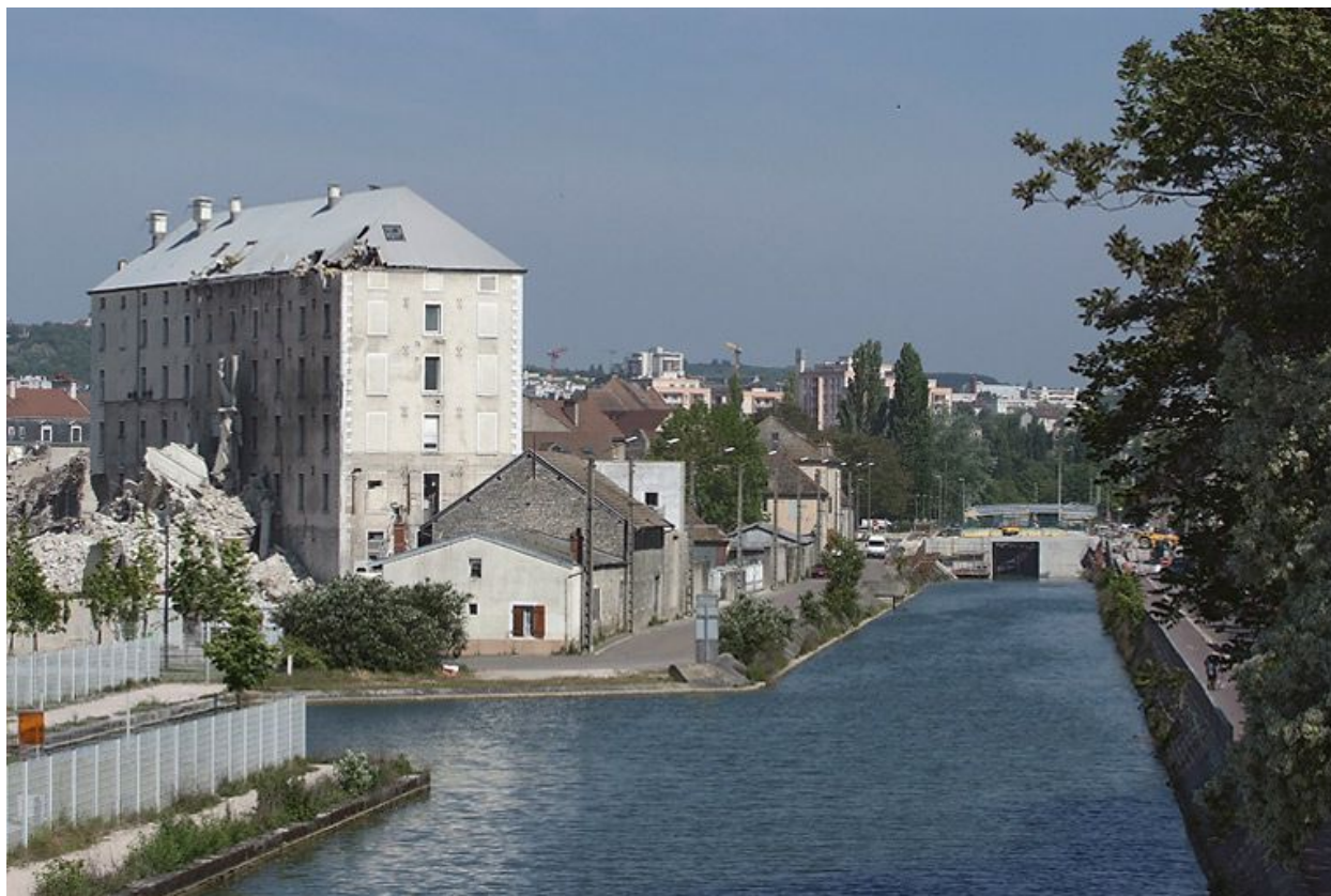
Les bâtiments en cours de démolition.
