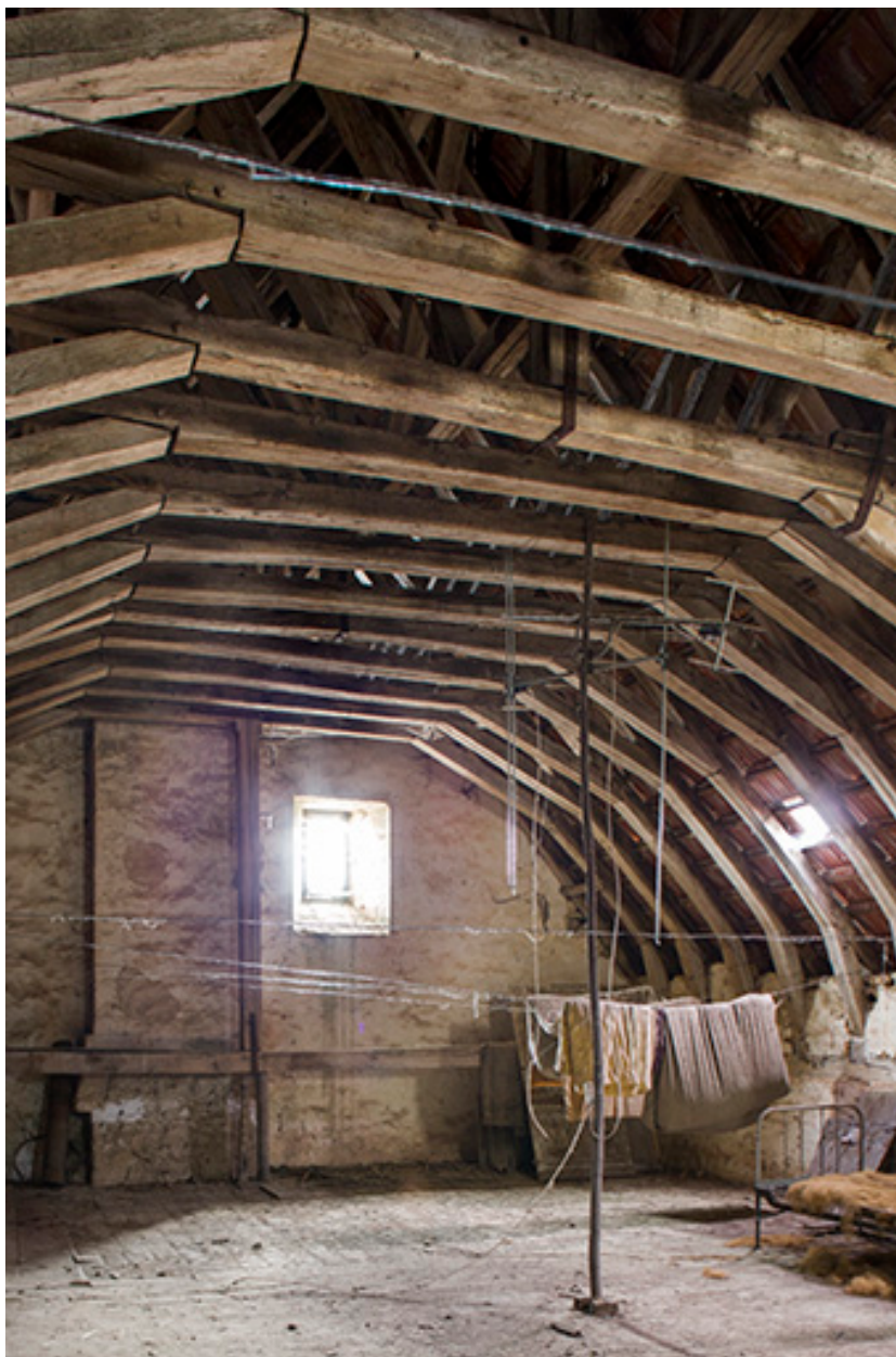
Vue rapprochée de la charpente.
