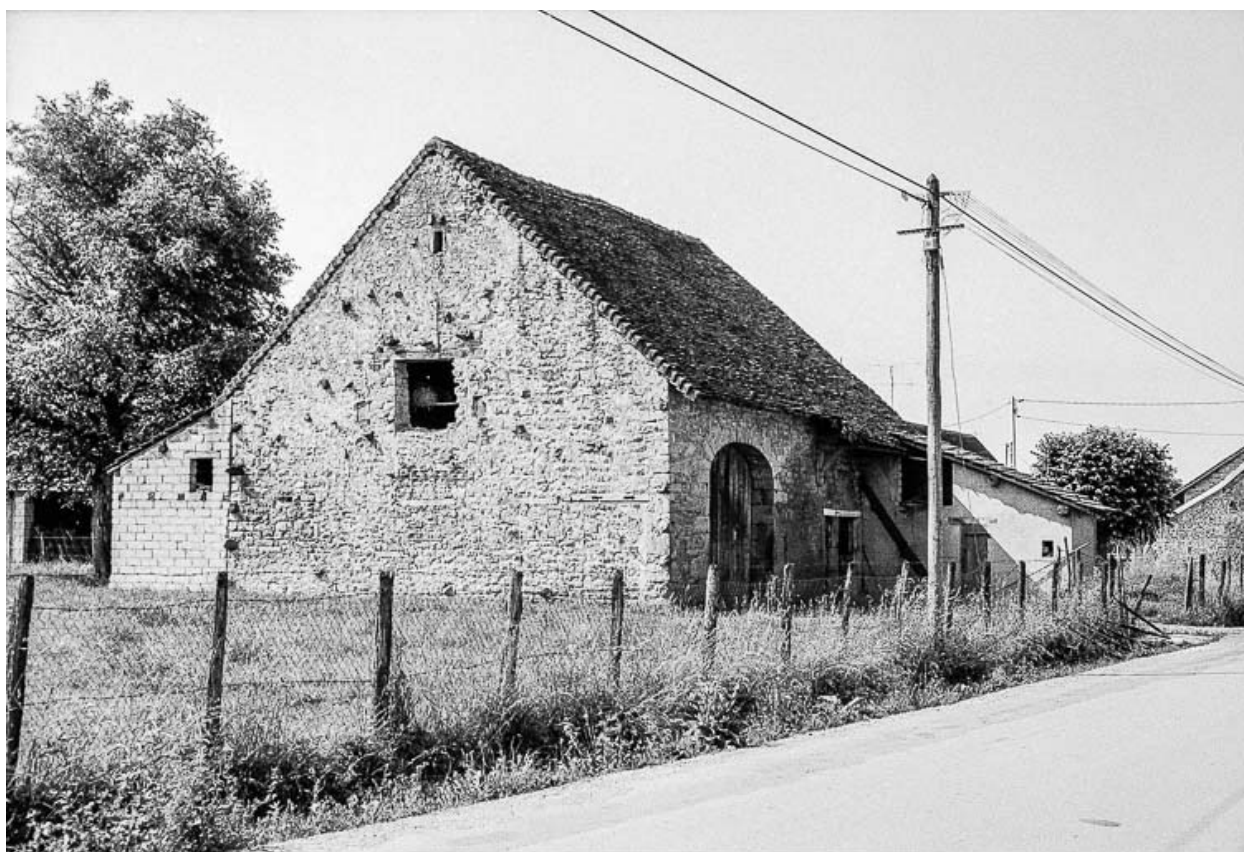
Ferme cadastrée 1984 B 552 : vue d'ensemble.
