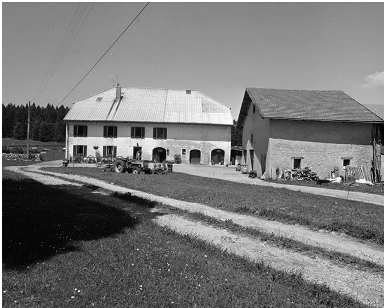
Vue éloignée de la façade antérieure.
