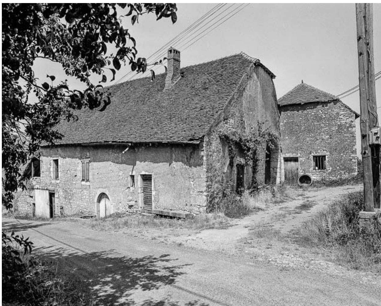
Façades antérieure et latérale droite.
