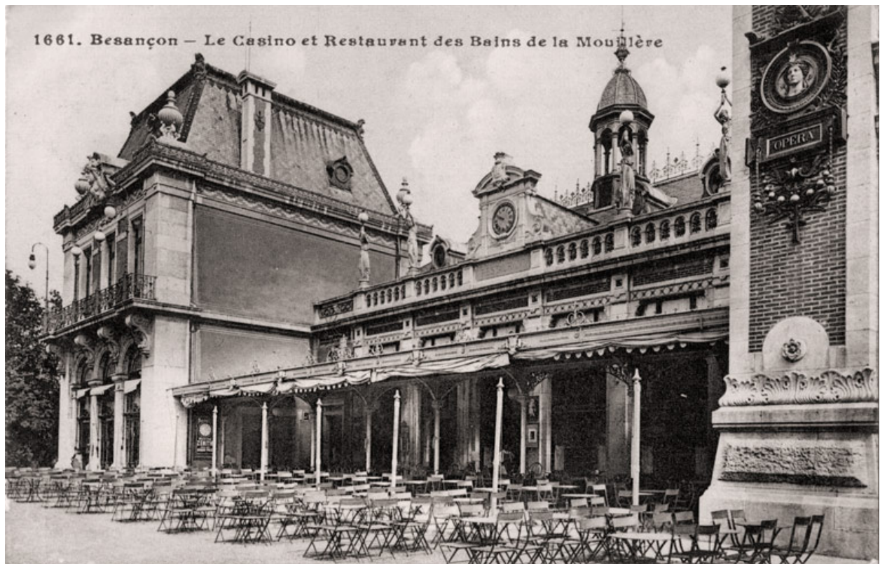
Façade principale, casino-restaurant (vers 1900).
