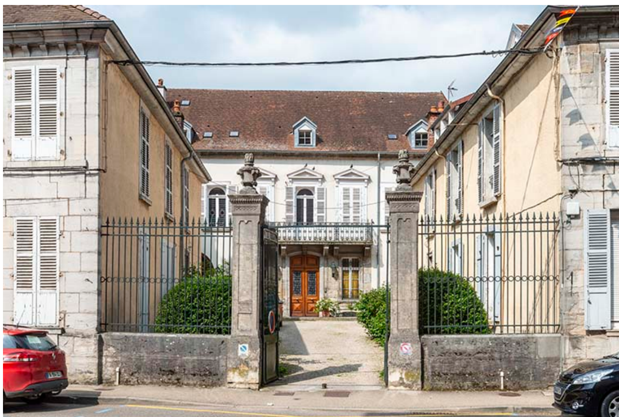
Vue de la cour depuis l'est.
