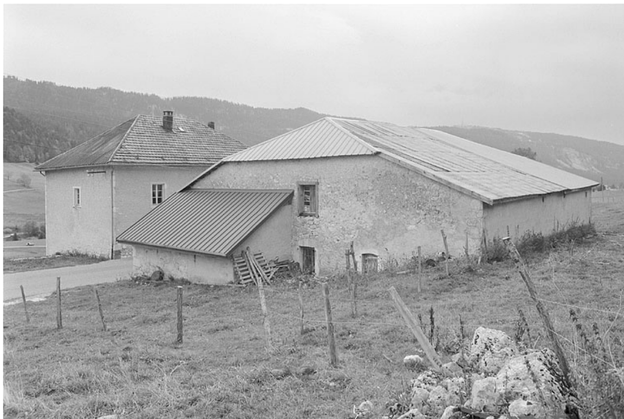
Façade postérieure et face nord-est.
