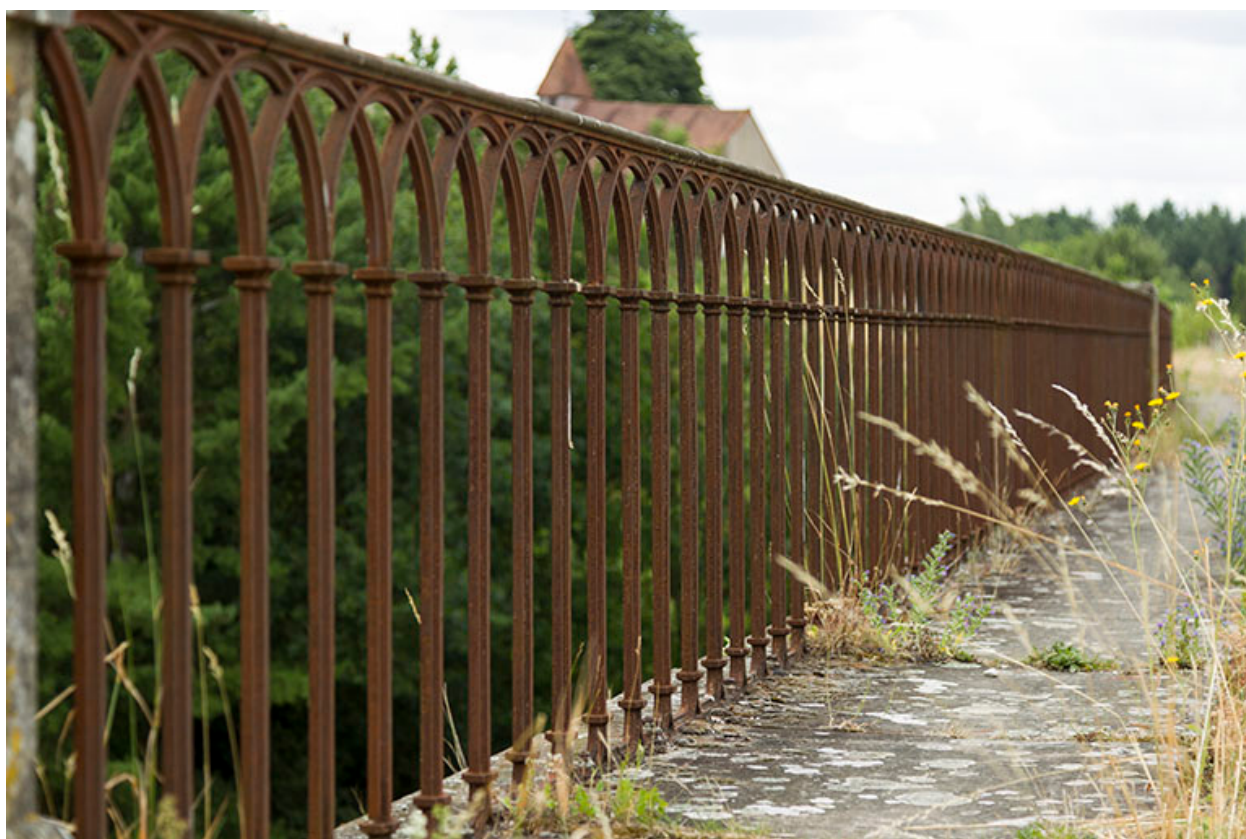
Détail du garde-corps.
