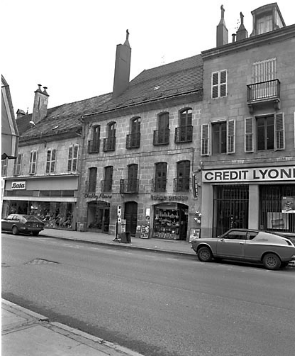
Façade sur rue de trois quarts.
