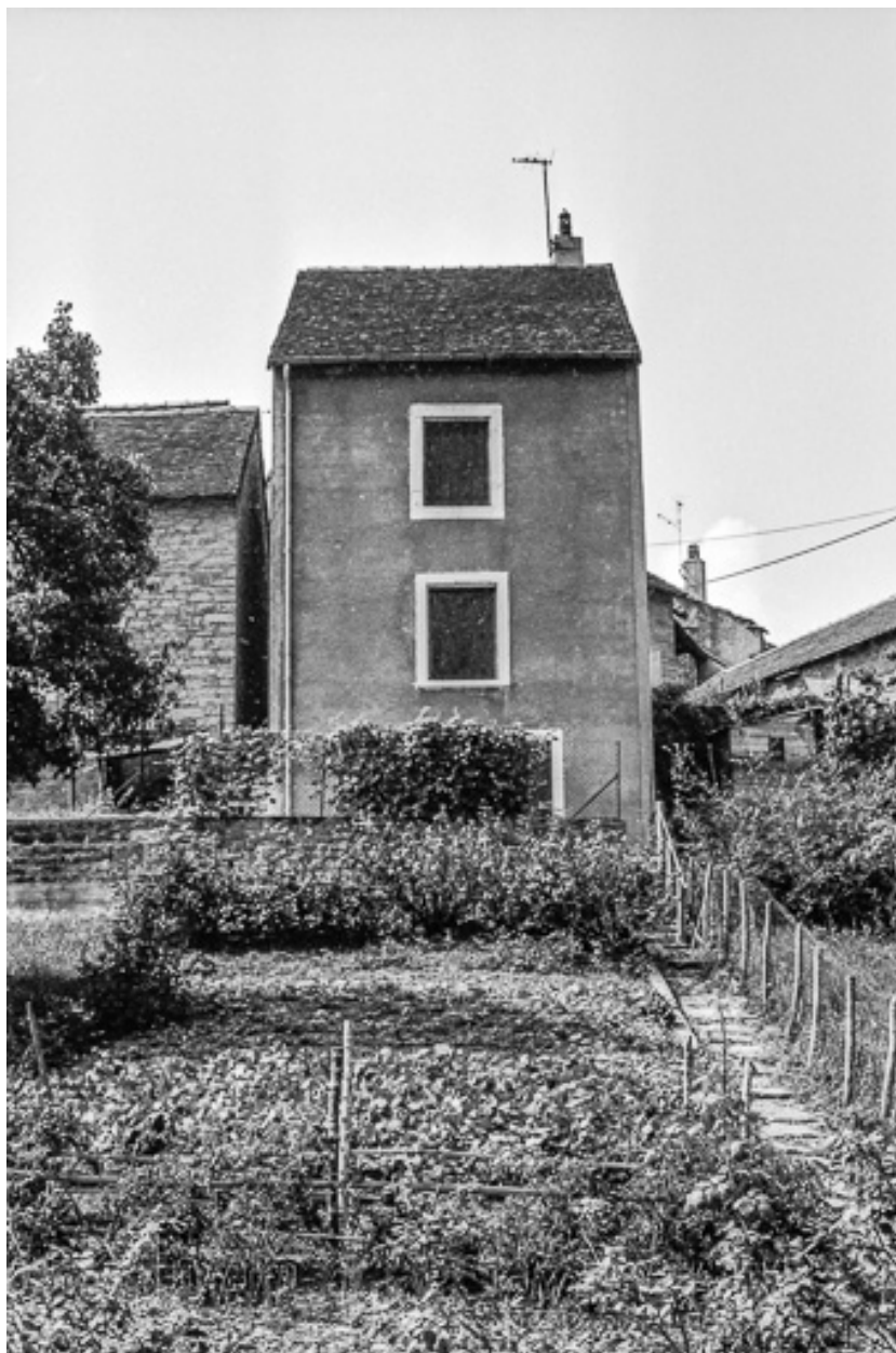
Maison cadastrée AD 114 : façade postérieure et jardin.
