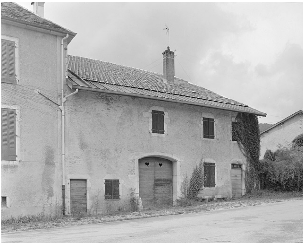
Face nord-est de la ferme.
