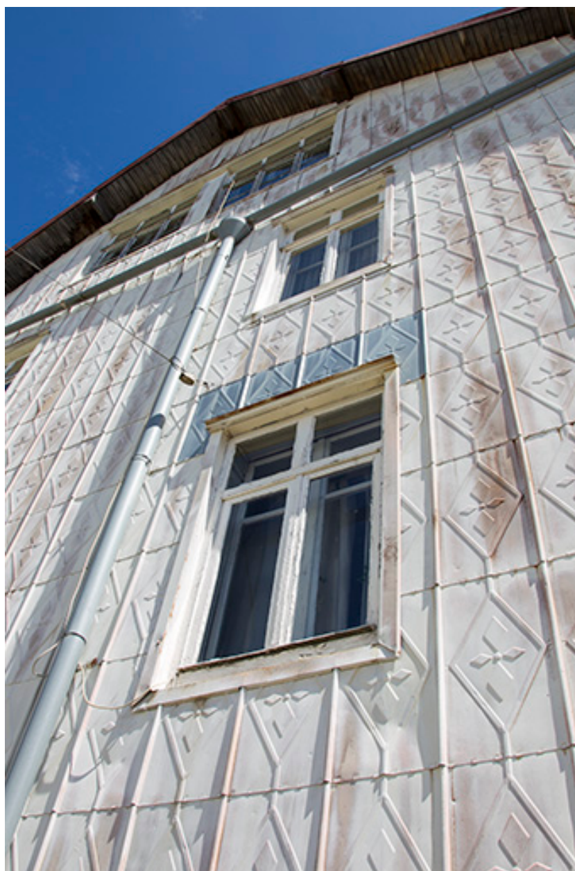
Façade latérale droite : fenêtres vues en contre-plongée.
