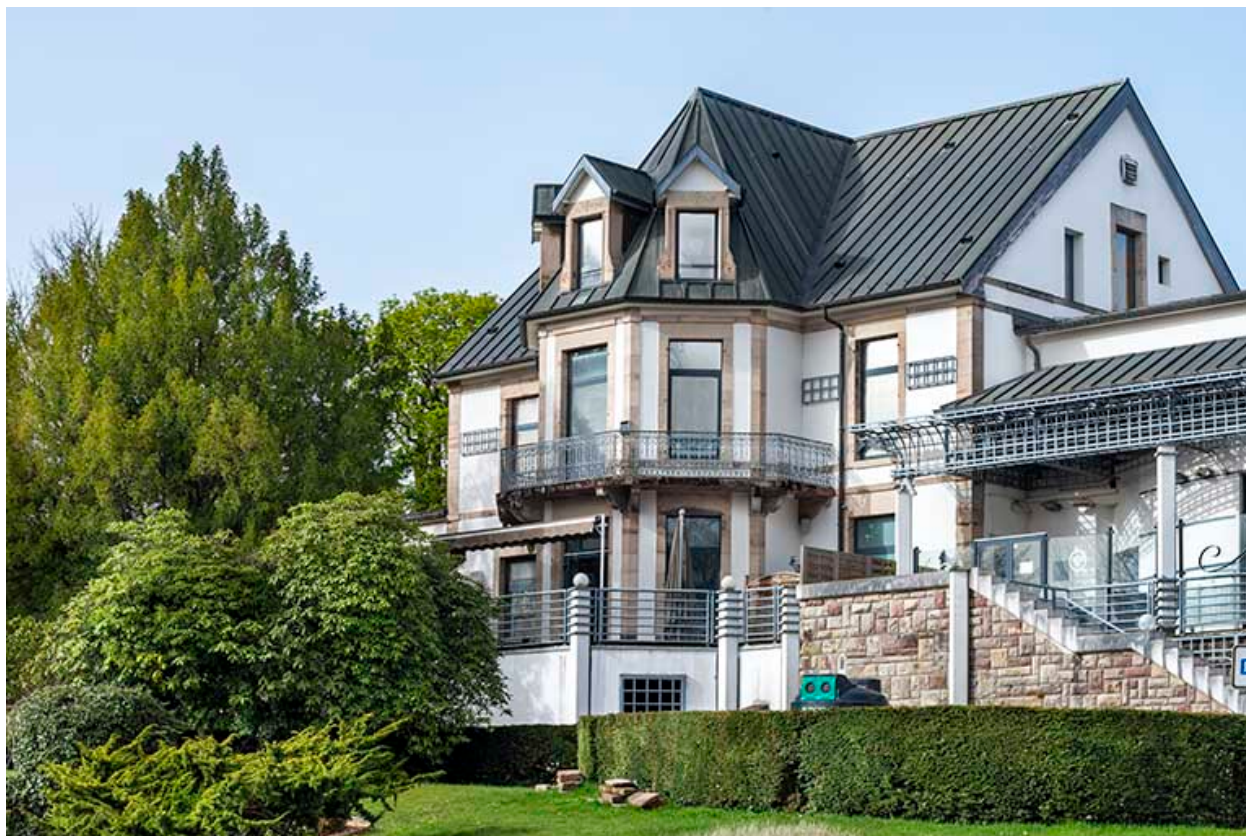
Maison, vue depuis le nord.
