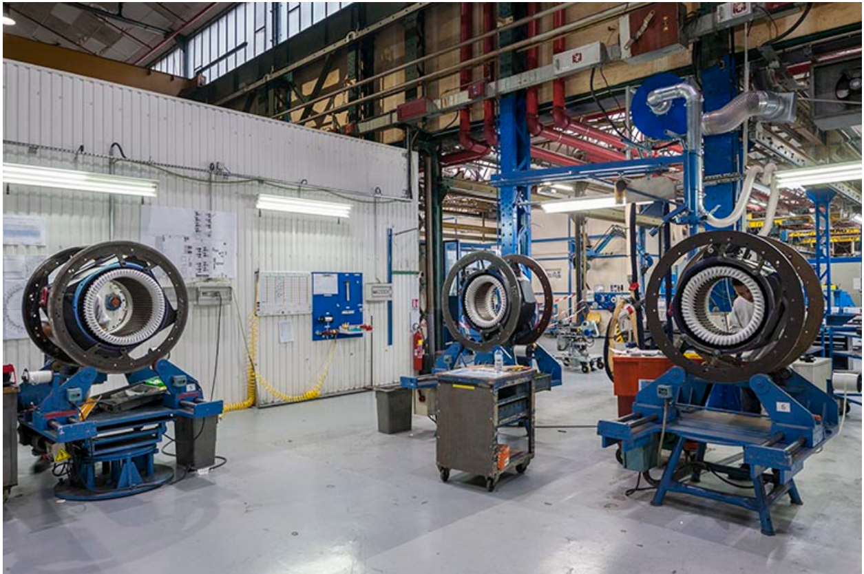
Atelier de bobinage. Equipement des stators.
