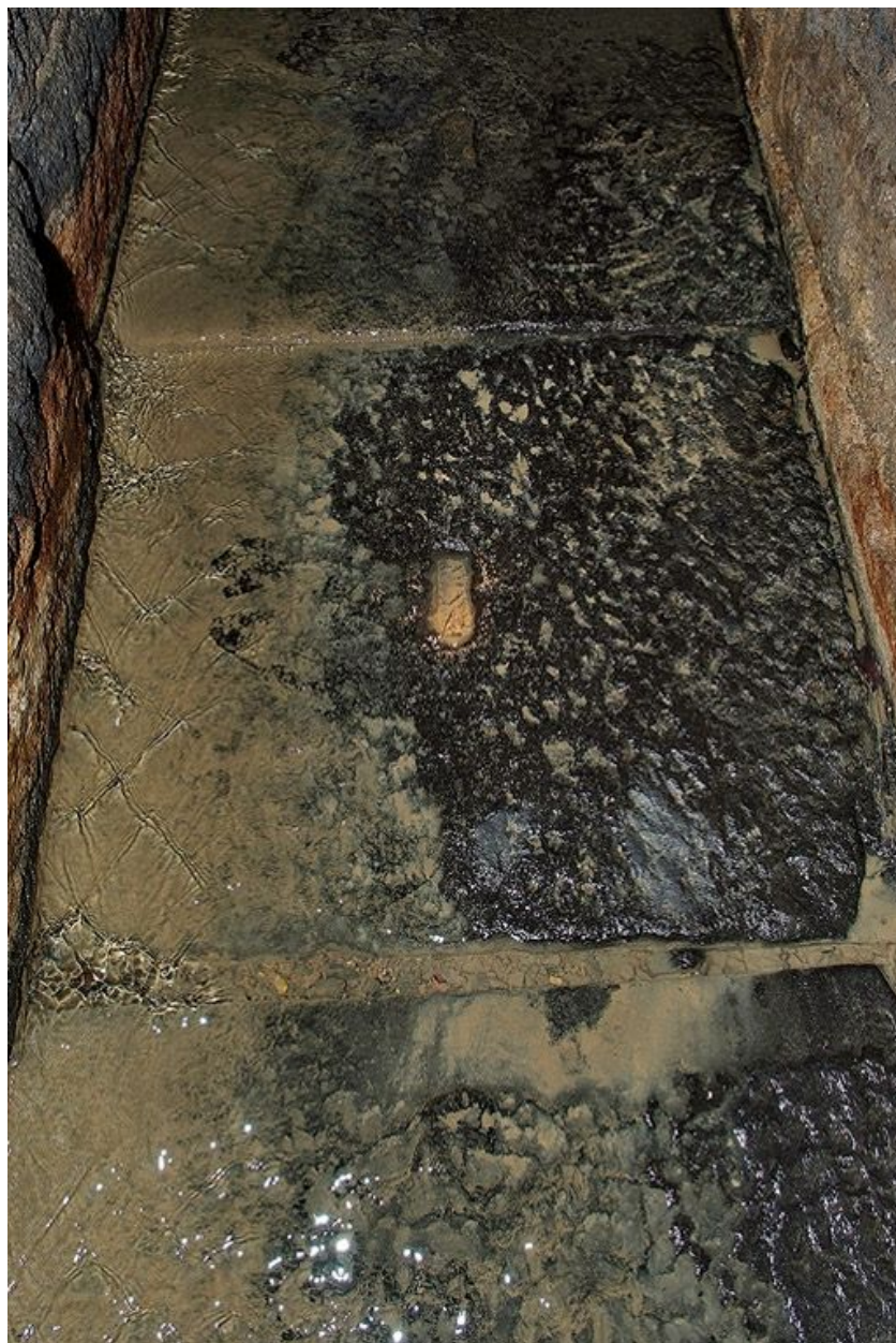
Deuxième galerie : détail des dalles du sol.
