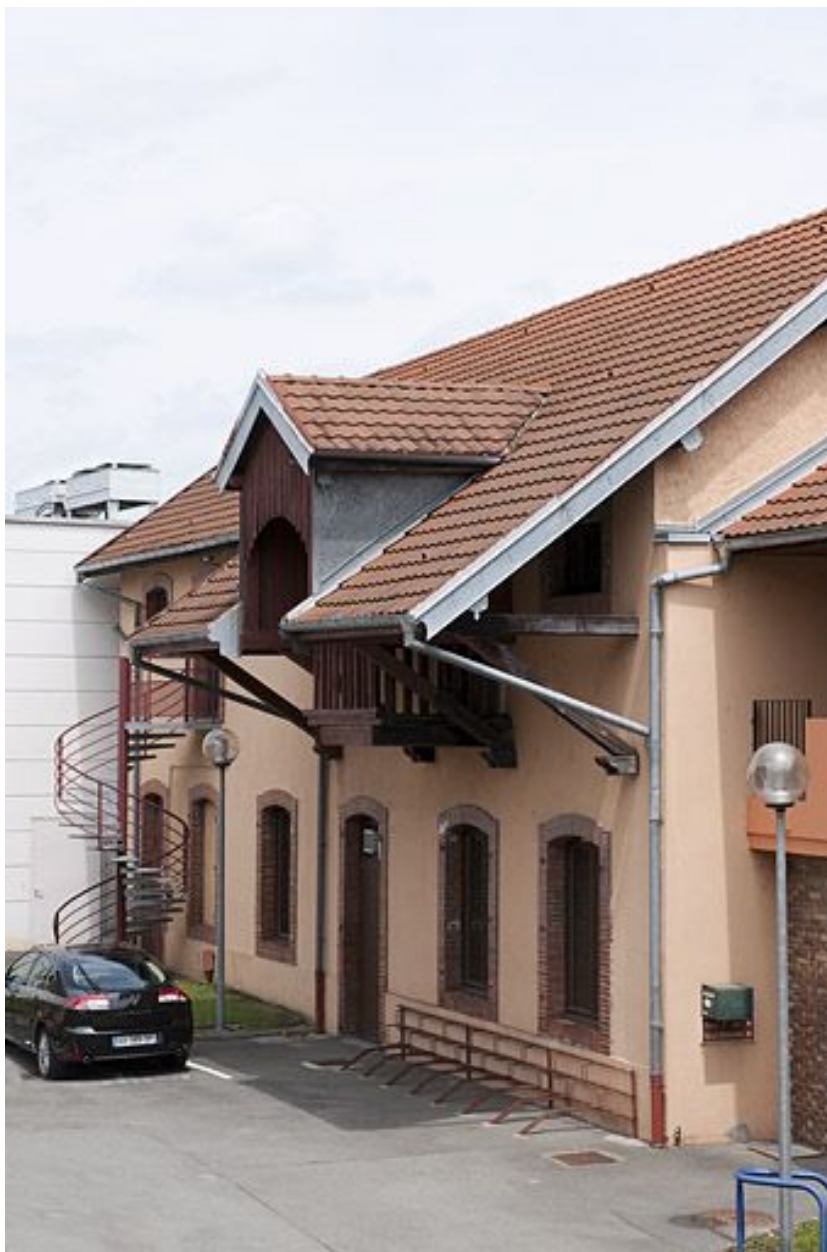
Façade des magasins de stockage.
