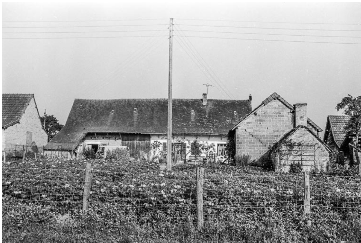
Ferme cadastrée 1956 A1 169 : façade antérieure.
