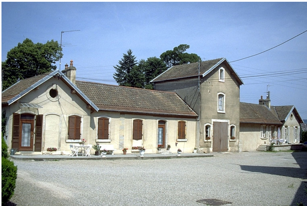
Façade antérieure du logement d'ouvriers.
