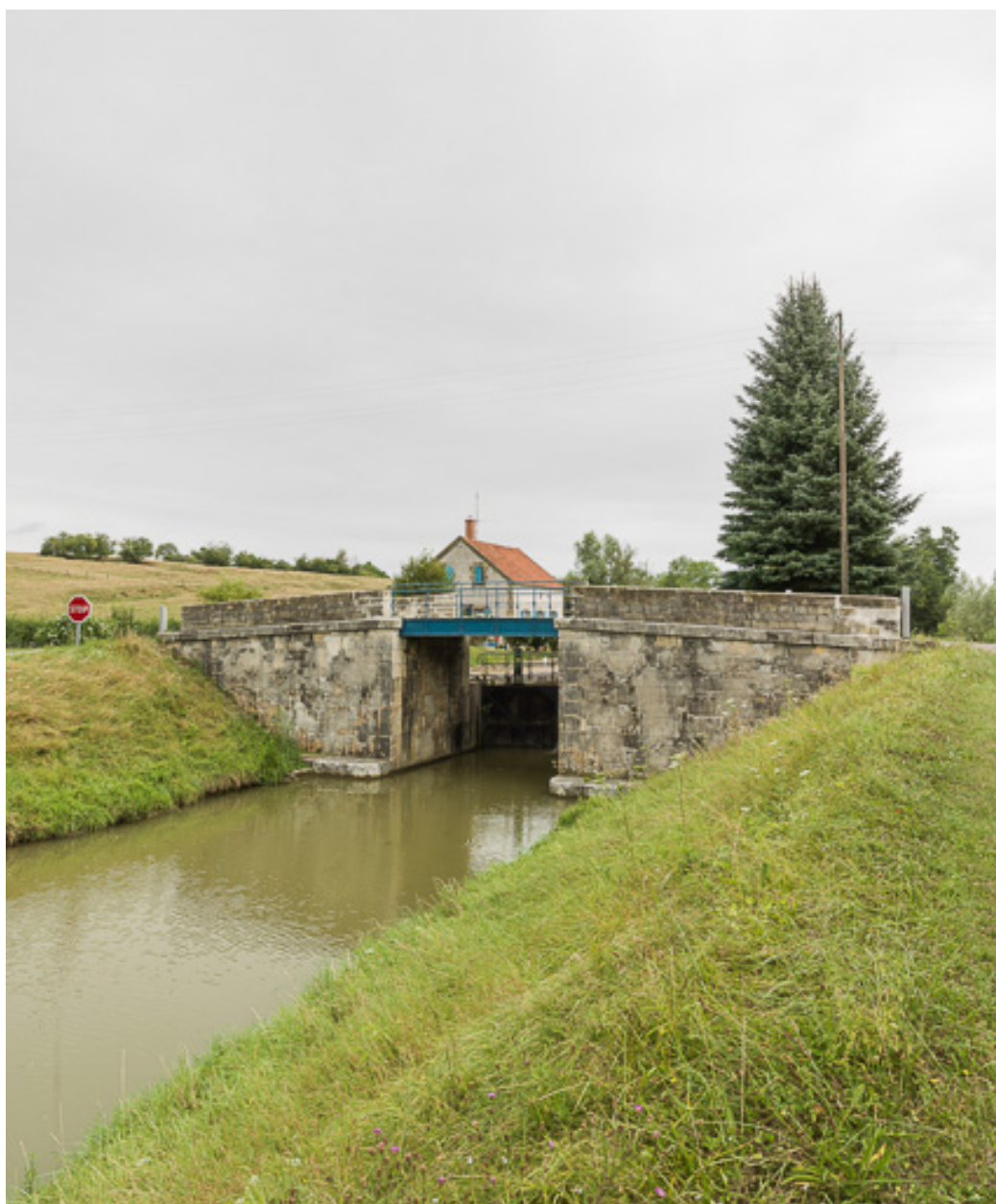
Vue d'ensemble du pont.
