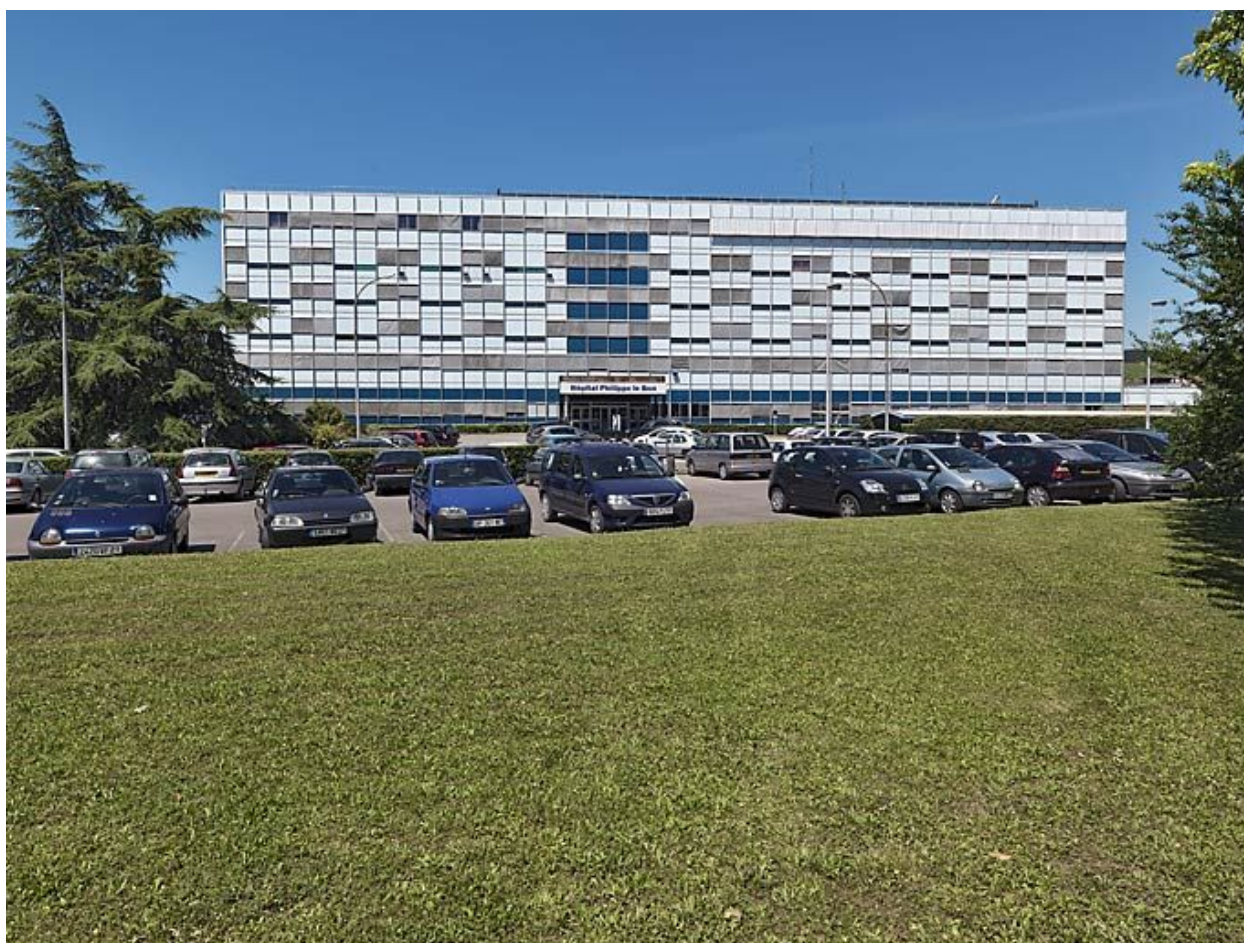
Bâtiment principal, façade.
