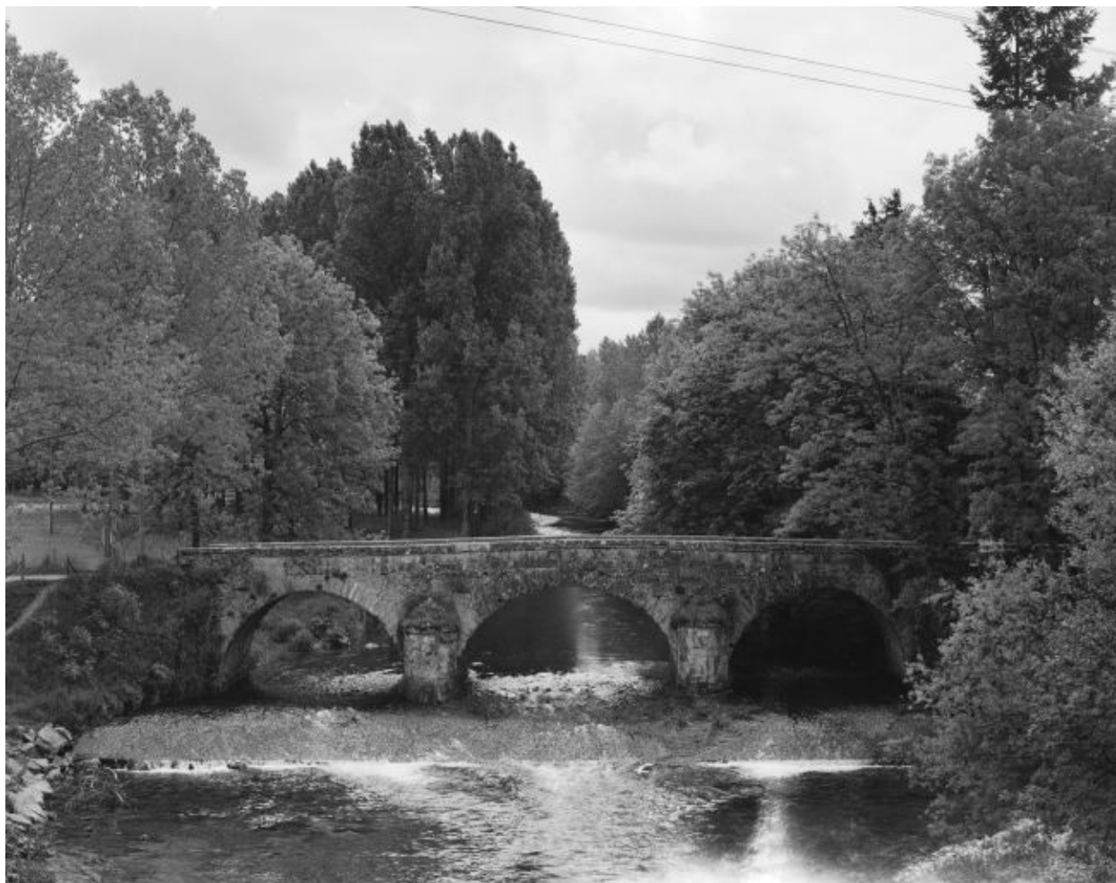
Face aval, vue de face.
