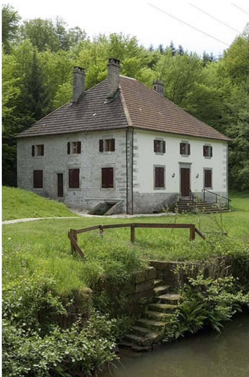
Logement patronal (1817) vu de trois quarts.
