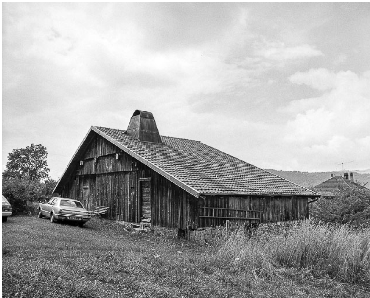
Ferme cadastrée 1966 AE 80 : façades postérieure et latérale gauche.
