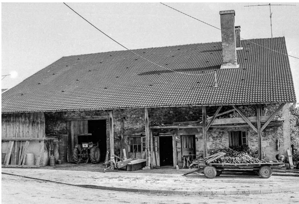
Gouttereau sur rue.
