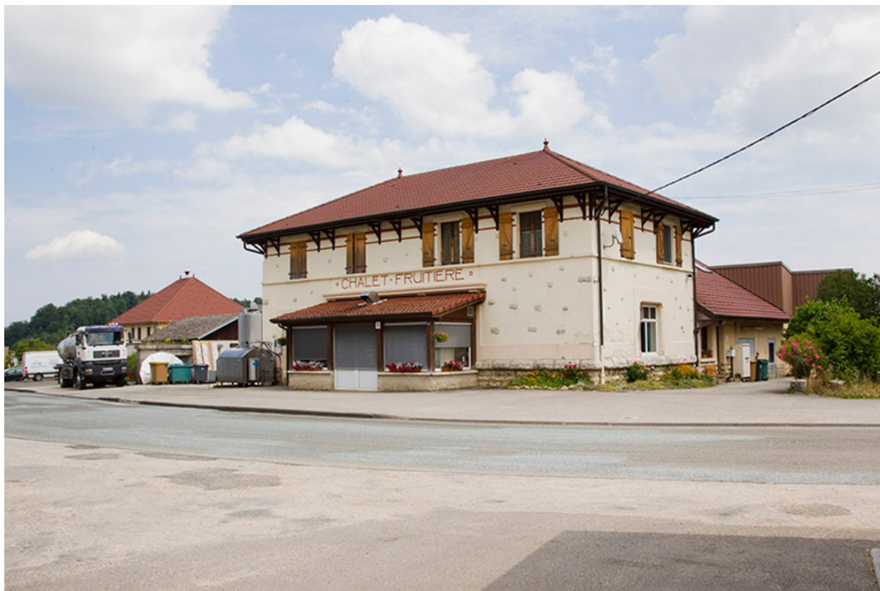
Façades antérieure et latérale droite.
