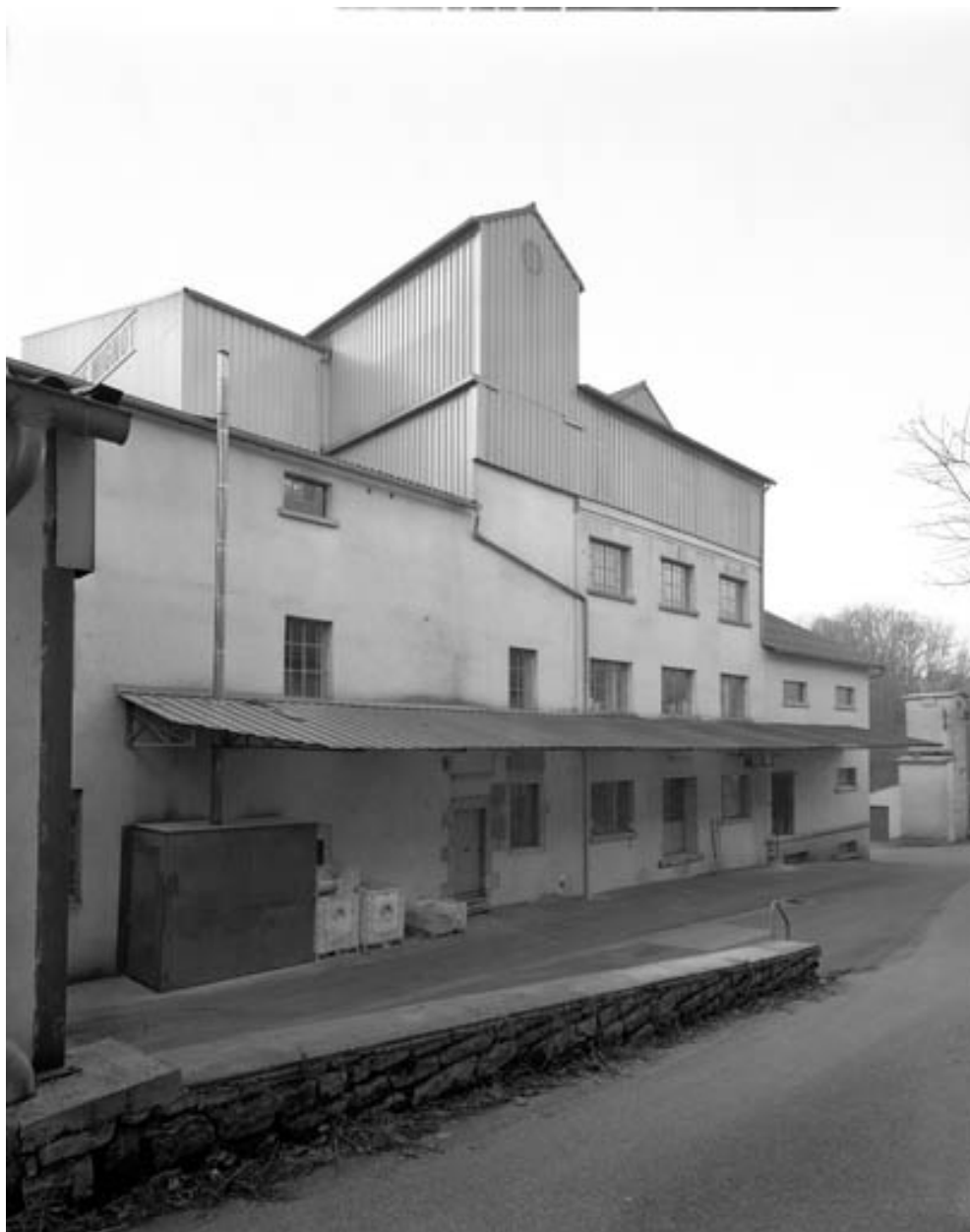
Ateliers de fabrication et magasin industriel.
