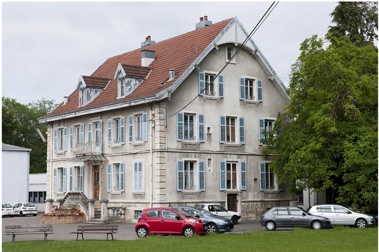
Logement patronal vu de trois quarts.
