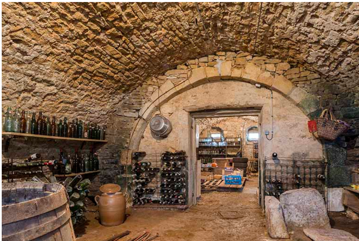
Cave voûtée, ferme de la Grande Vigne.
