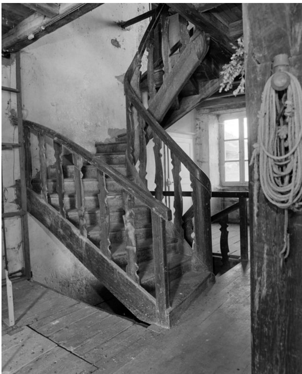
1er étage. Escalier, détail.
