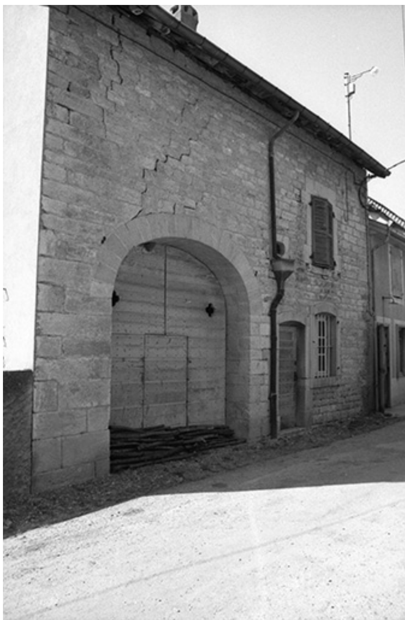
Ferme située le long du chemin départemental n° 209 E.
