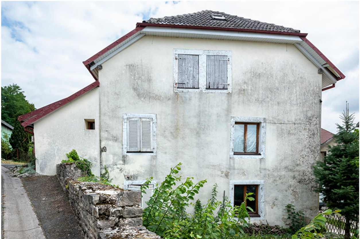
Bâtiment de 1723 : façade latérale gauche.
