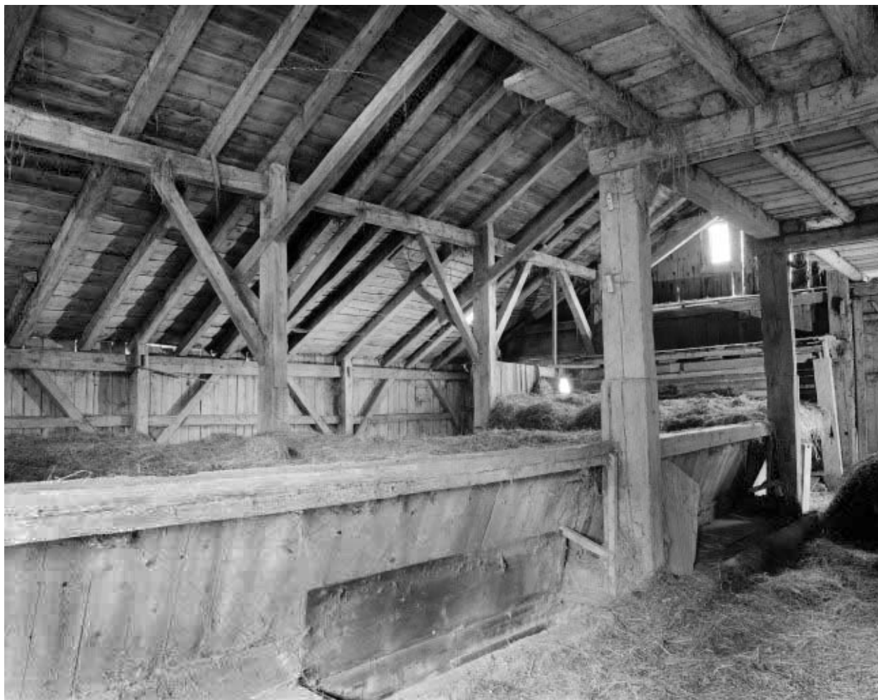
Charpente vue de l'aire de roulage.
