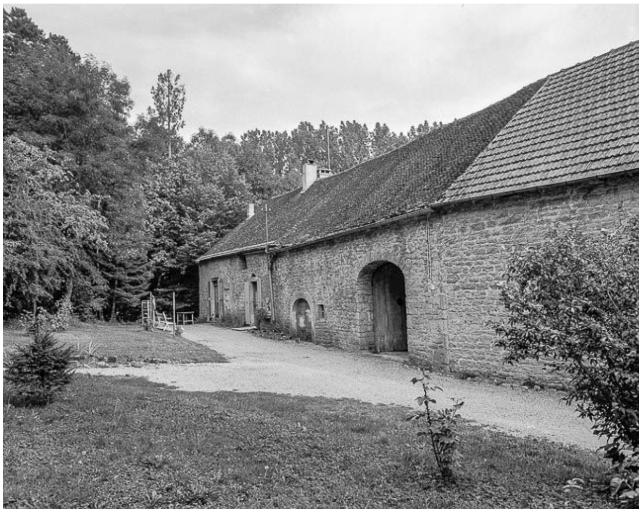
Façade sur cour.
